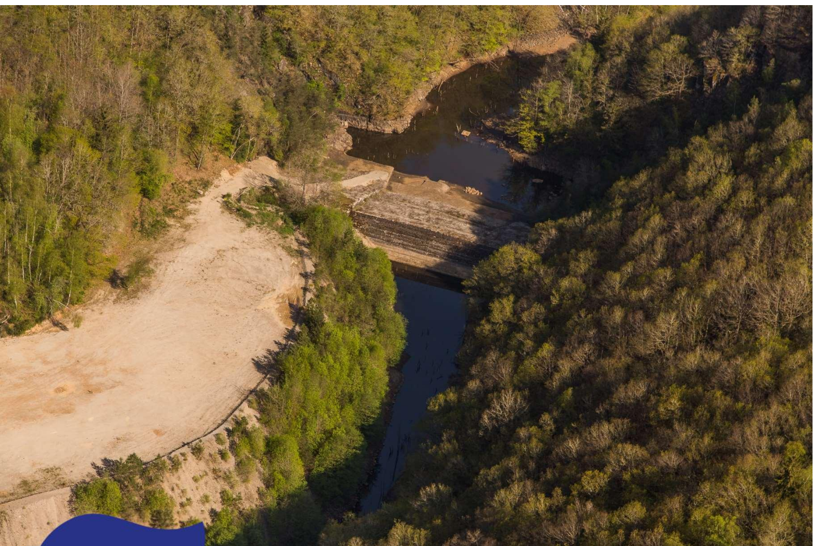
Barrage du Chavanon, vue aérienne (C. Bogaerts, 2018)
