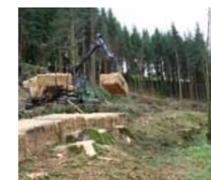
Mise en place d'un barrage filtrant en paille pour limiter l'apport de fines dans le cours d'eau
