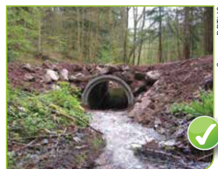
Buse circulaire enterrée au 1/3
