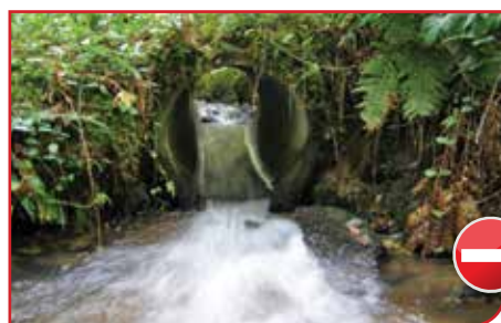
Trop forte vitesse d'écoulement.
