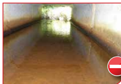
Lame d'eau insuffisante.
