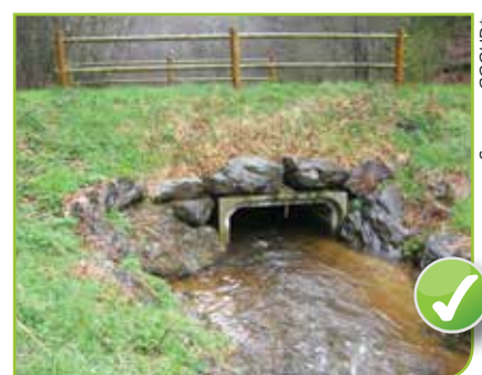
Buse cadre enterrée au 1/3
