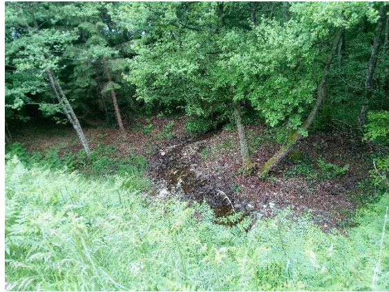
Photos 27 à 32 : ouvrage hydraulique Eau du Bourg et cours d'eau – prospections 2025
