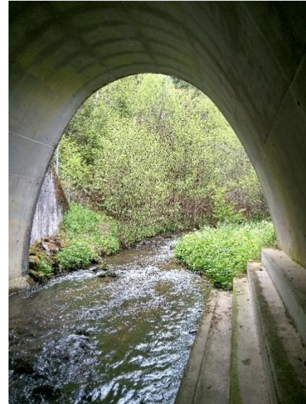
Exemple de banquette en béton – GREGE 2018
